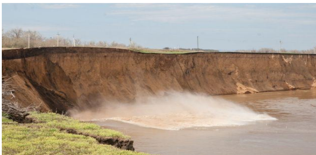
Расми12. Эрозияи соҳил дар обанбори Қайроқум
