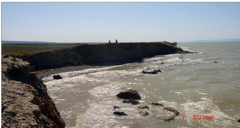
Расми 10. Эрозияи соҳил дар обанбори Қайроқум
